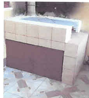
Foto 2: Sustitución de estufa rural.
