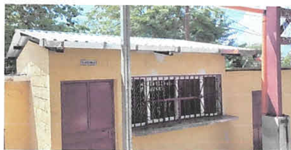
Foto 6: Sustitución del techo de la cocina.
