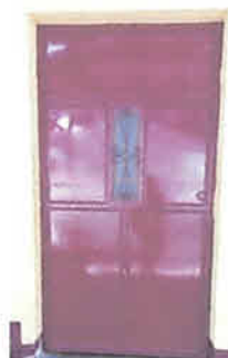
Foto 4: Mantenimiento de pintura a puertas de la escuela.
